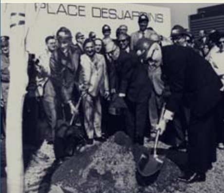
Mai 1972. Levée de la première pelletée de terre par Bernard Pinard, Ministre de la Voirie et des travaux publics, Jean Drapeau, Maire de Montréal, et Alfred Rouleau.
